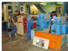
-2- Demontage zu Beginn der Arbeiten
