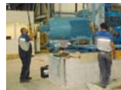
-4- Motormontage auf ausgerichteter Grundplatte
